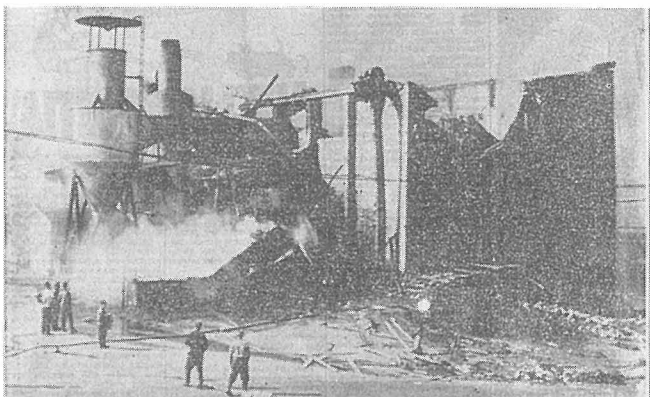
Vaajakosken lastulevytehtaan yksi 80-metrin pituinen seinä luhistui räjähdysen voimasta heti alkuvaiheessa.
