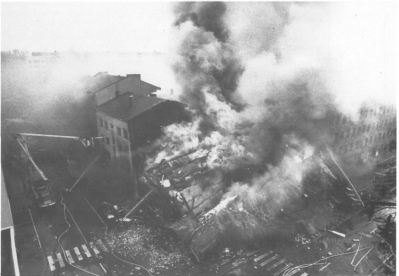
Vuikerroksinen tavaratalo Turussa Brahenkadun ja Yliopistonkadun kulmassa sortui perjantaina 11.11.1983 iltapäivällä noin puolen tunnin kuluttua syttymisestä. Oleellista sortumisessa oli, että yhden teräsbetonipilarin murtuminen on saattanut johtaa koko rakennuksen sortumiseen. Sortunut osa oli rakennettu v. 1956 ja välipohjat olivat teräsbetonia. Kuvassa vasemmalla näkyvä 4-kerroksinen rakennus jouduttiin palovaurioituneena purkamaan. Alkusammutustoimenpiteet epäonnistuivat, koska paikalta ei löytynyt alkusammutusvälineitä. Palon syy: murhapoltto. Korvaukset olivat n. 30 mmk.
