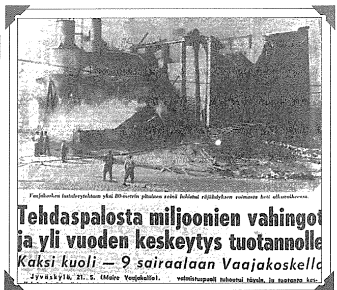
SOK:n Vaajakosken tehtailla tapahtunut lastulevytehtaan räjähdys v. 1966 aiheutti paljon julkista huomiota tehdastyöpaikkojen turvallisuudesta.
