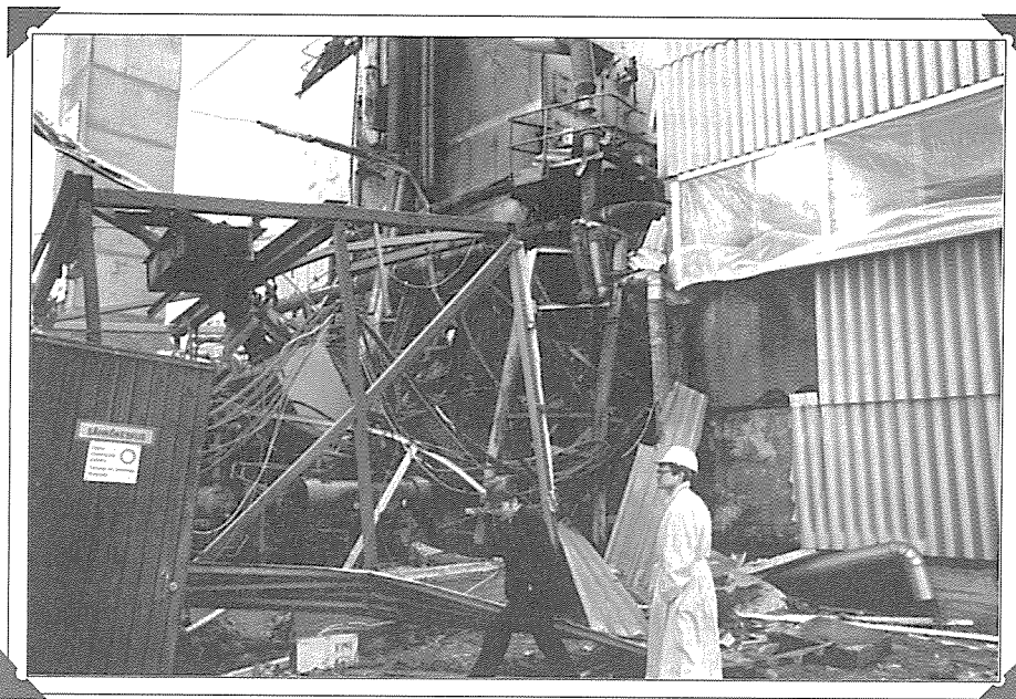
Räjähdyks Outokumpu Oy happitehtaalla Harjavallassa 22.4.1989. Omaisuus- ja keskeytyskorvaukset yhteensä 130 mmk (vuoden 1997 rahanarvon mukaan) sisältäen merkittävästi ylimääräisiä kustannuksia, joiden avulla minimoitiin uhkaavat seurausvahingot mm. lannoite- ja sellutehtaille.
