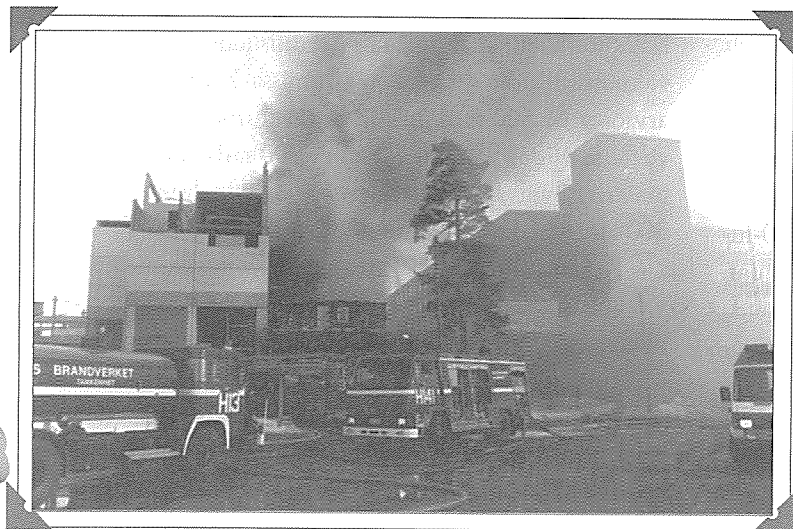
Kolme kuvaa Standard Electric Puhelinteollisuus Oy:n palovahingosta 18.3.1987. Palo sai alkunsa SEP:n toimitalojen viereisen uudisrakennuksen elementtiasennustöistä. Paikalleen asennetun elementin nostokorvakkeita katkaistiin polttoleikaten- Kuumentunut nostokorvake putosi varastorakennuksen akryylisen kattoikkunan päälle, sytytti sen palamaan, pudotti ikkunan alas varastoon, jossa oli pakattuja tuotteita ja raaka-aineita, jotka syttyivät. Omaisuusvahingot olivat vuoden 1987 rahassa noin 50 mmk, keskeytysvahingot noin 40 mmk.
