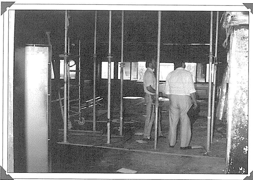
Palo Esselte Oy:n konttorirakennuksessa 16.7.1990. ATK- ja konttorikoneiden maahan tuontia, vähittäismyyntiä sekä huoltoa harjoittavan liikkeen 4-kerroksisessa konttori- rakennuksessa tuhoitui keskusyksikkötietokone, samoin kun lähes kaikki läheisyydessä olleet mikrot ym. konttorikoneet. Toisen kerroksen konttoriosa paloi käyttökelvottomaksi; kaikissa kerroksissa oli noki- ja savu- sekä niihin liittyviä syöpymisvaurioita. Omaisuus- ja keskeytyskorvaukset yhteensä yli 28 mmk.
